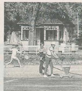
Bis Anfang der 1990er-Jahre wurden die Spiellinien mit weißer Farbe manuell mit einem Linienwagen aufgetragen. Heute sind weiße Plastikkleben auf dem roten Sand befestigt.
