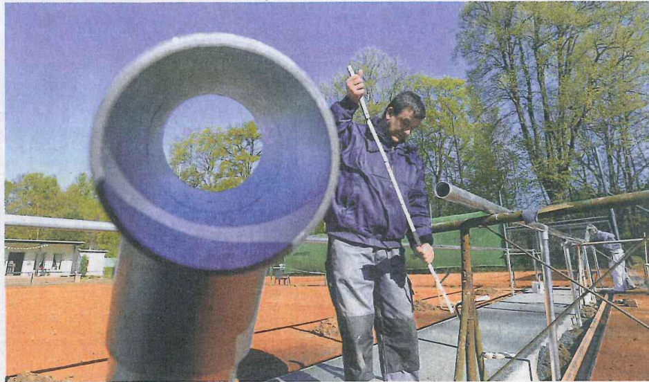
Auf der Anlage der Chemnitzer Tennisgemeinschaft Stadtpark ist in den vergangenen Tagen noch an der Beseitigung von Hochwasserschäden aus dem Vorjahr gearbeitet worden. Im Bild: Eddy Wagner beim Bau eines Barriersystems gegen Überflutungen. FOTO: ANDREAS SEIDEL
